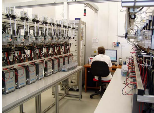
Equipo de contraste de los contadores ELMA con los bastidores fijos con colocación vertical estándar de contadores
